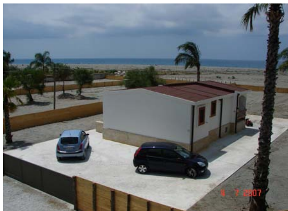
La casa mobile a Falerna
